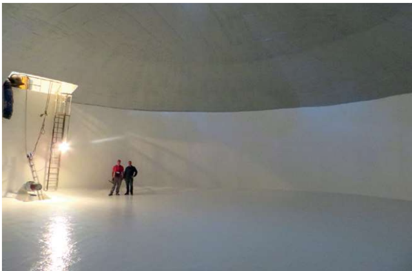
La société Resina a effectué la réhabilitation de ce bassin d'eau potable en Corse en le revêtant d'une couche intérieure de résine epoxy.
