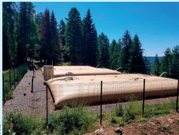
3 citernes ACS de 150 m 3 chacune - Régie d'Eau Azur ont été installées à Roubion (06) pour augmenter les capacités de stockage du réseau d'eau potable.
