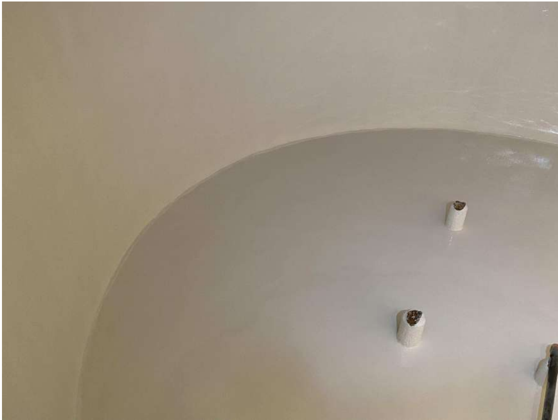
Etanchéité d'un réservoir d'eau potable en SOUPLETHANE WP, mars 2020
