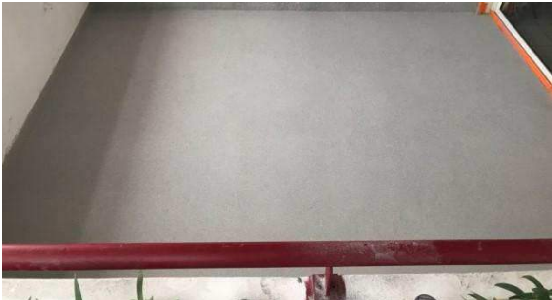
Balcony renovation, Souplethane 5, PU Aqueux, Poudrec
