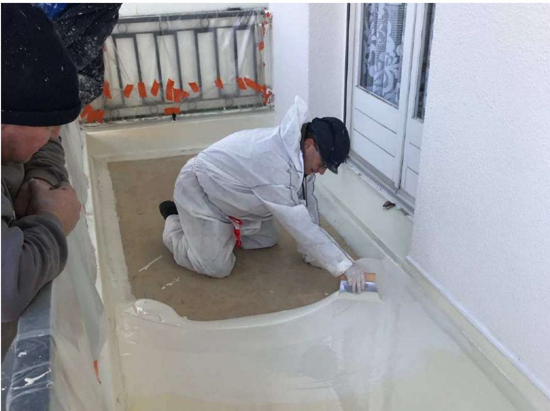
Mise en œuvre balcon, Souplethane 5
