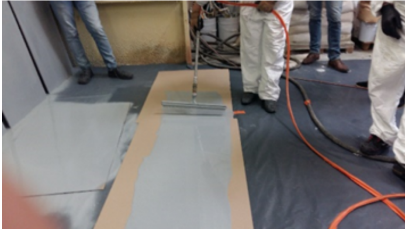
Figure 1 - Application mécanique de la résine SOUPLETHANE 5
